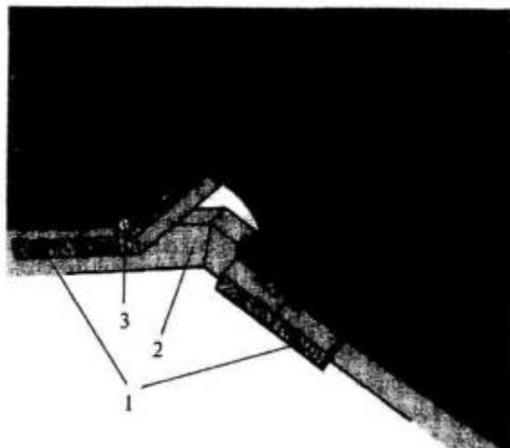
1 - дополнительные доски; 2 - стропила; 3 - уплотнительный профиль
